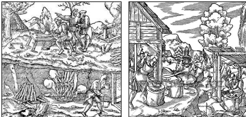
Figura 1 Tipo de fragmentação de rochas durante o século XVI. À esquerda: por efeito térmico (dilatação e contração), à direita: fragmentação por ação mecânica (Hoover & Hoover, 1912)
