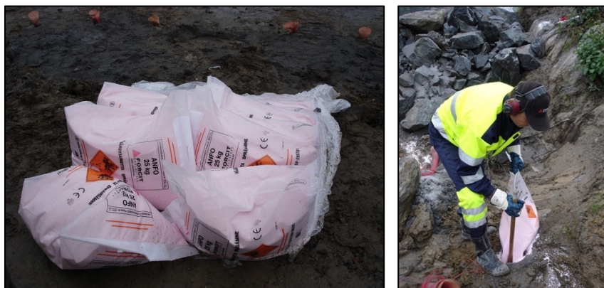
Figura 15 À esquerda: sacos 25 kg de ANFO; à direita: carregamento direto nos furos de detonação (retirado de Wikipedia "ANFO", acesso em 26/06/19 às 13:31, https://pt.wikipedia.org/wiki/ANFO#/media/Ficheiro:Anfoa.jpg )
